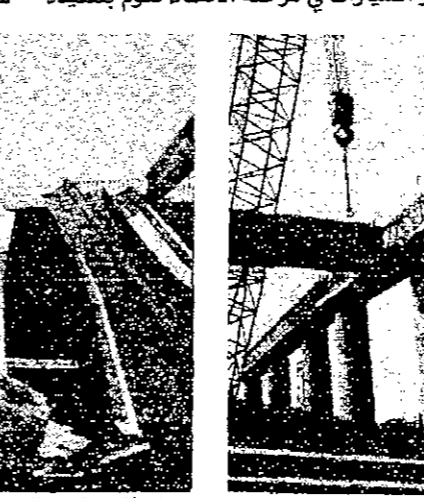
تهشم في جوانب الخرسانة بالجسر الرابط
